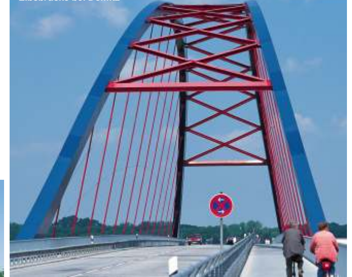
Elbebrücke bei Dömitz
